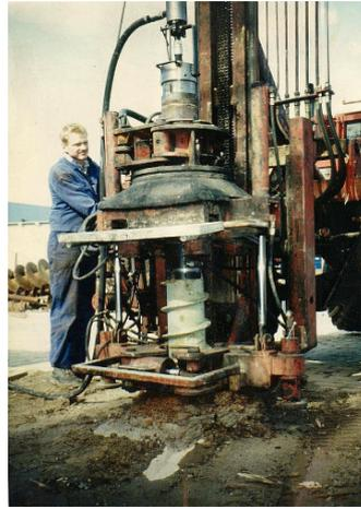
Abteufen der Hohlbohrschnecke zur Durchörterung des Müllkörpers
