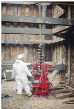
Eindrehen der Hohlbohrschnecke im Basisbereich des Müllkörpers
