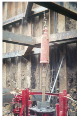
Einrammen der ORKUS-Sonde in die Basisdichtung
