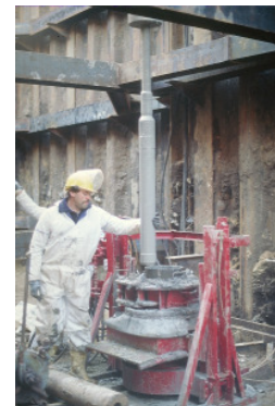
Ziehen der Sonde nach erfolgter Kerngewinnung
