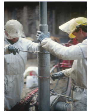
Öffnen der ORKUS-Sonde zur Entnahme des DEKADUR-Liners
