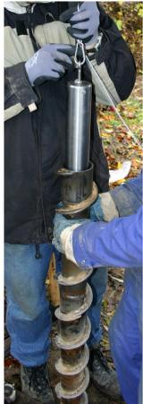
Einbringen der Pilotspitze in die Hohlbohrschnecke
