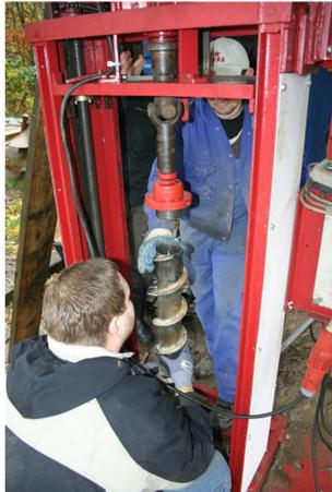
Anbringen der (Schraub-) Verbindung zwischen Motoreinheit und Gestänge, sowie Verbindung der Pilotspitze mit der Kontrolleinheit
